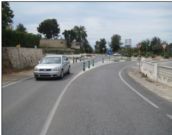
Situación actual con las cuatro balizas H-75 de EVA colocadas.
