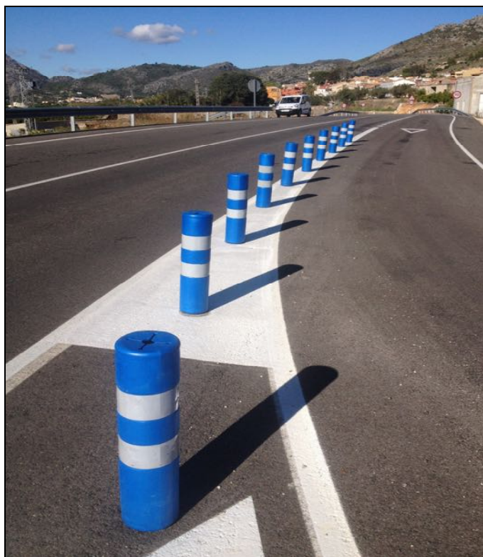
Estado del balizamiento a 6-11-2012 tras la reposición con las balizas de EVA.
