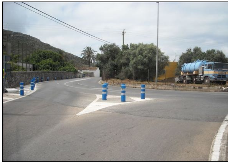
Situación antes de la prueba con balizas H-75 de polietileno.
