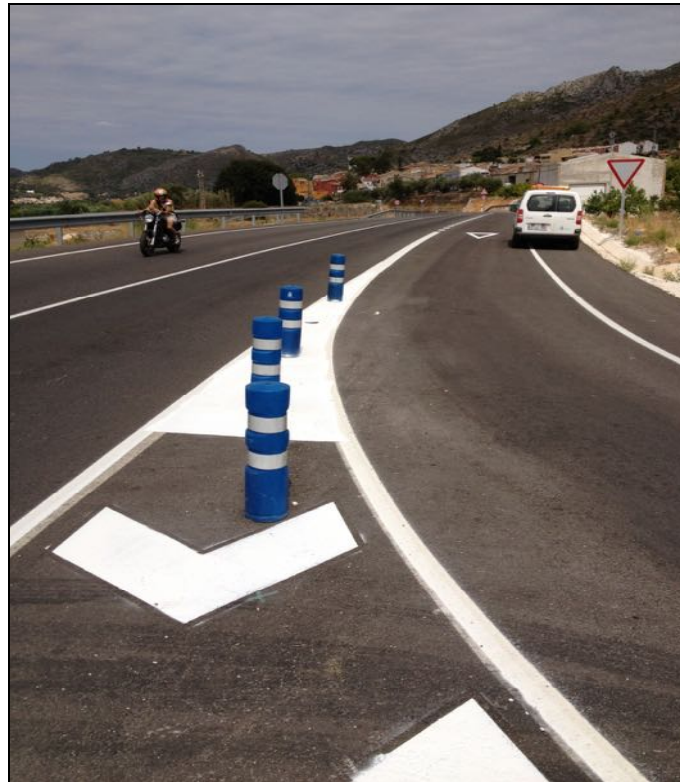
Estado del balizamiento antes de la modificación en julio de 2012.
